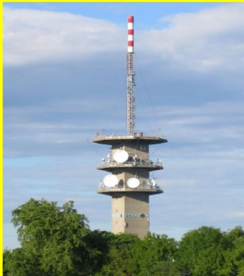
De RTV toren op de locatie Malmö / Jägersro, (SWE). The RTV tower at the location Malmö / Jägersro, (SWE). Teracom, via Gösta van der Linden.
